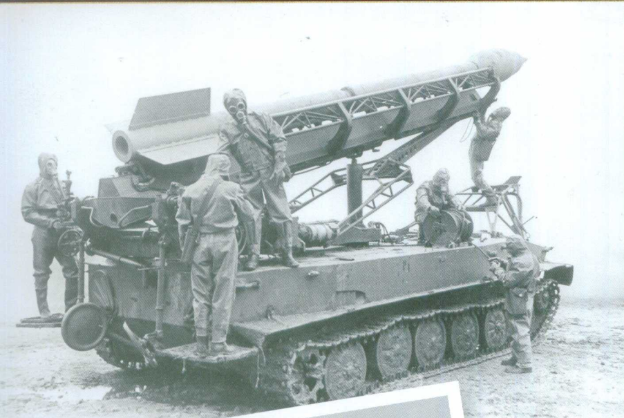
★ Дезактивация пусковой установки 2П2 ракетного комплекса 2К1 «Марс».
